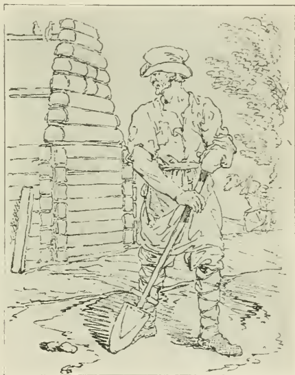
За земляными работами (Литинсонъ).
