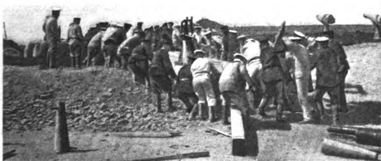
Работы по возведенію укрѣпленій на сухопутномъ фронтѣ.
