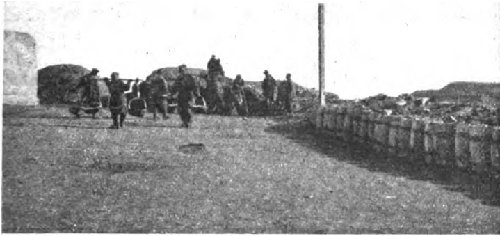
Работы по возведенію укрѣпленій на сухопутномъ фронтѣ.
